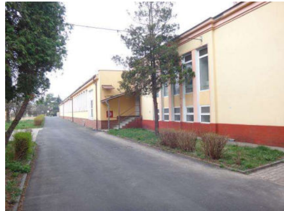
hlavní výrobní objekt
