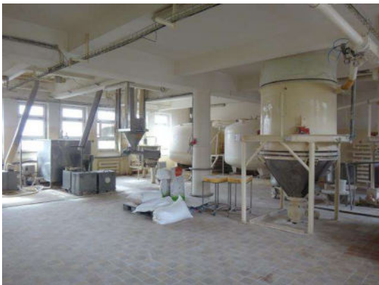
hlavní výrobní objekt
