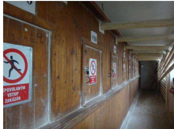
hlavní výrobní objekt
